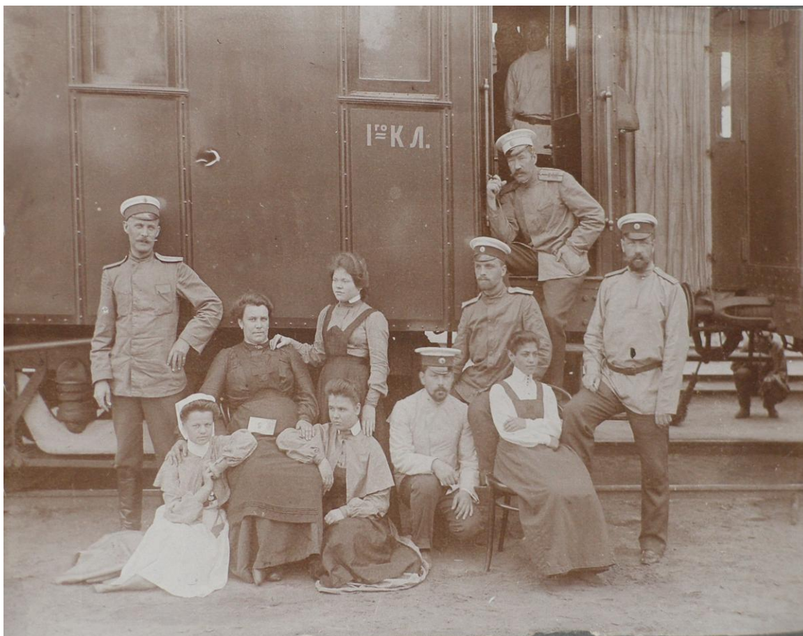
Фото. А.М. Никольский (первый ряд, второй справа) у санитарного вагона
